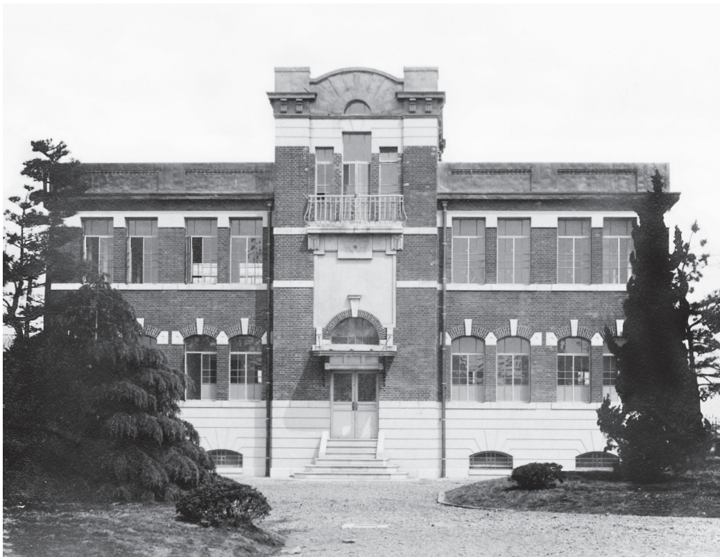
「仮実験室研究室第一附属屋」（大正14年）
