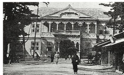
1-022 県立福岡病院本館
